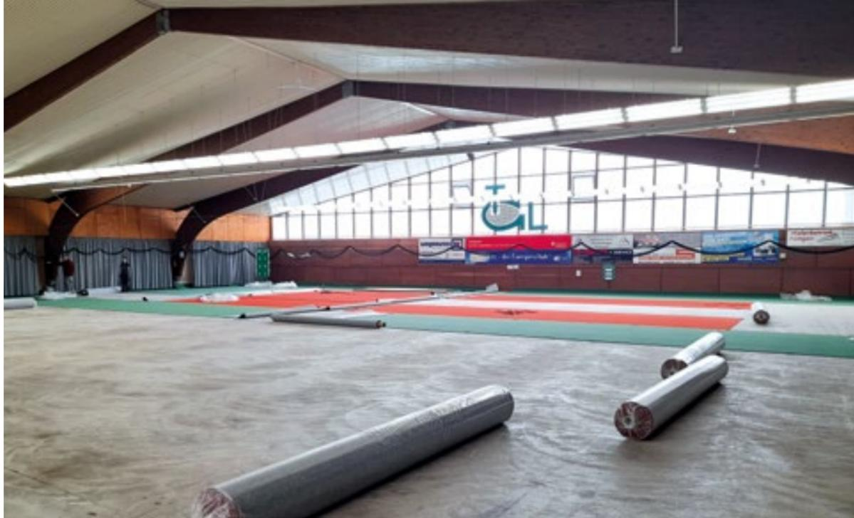
Ab dem 09. Mai konnte dann, wie geplant, mit der Verlegung des neuen Hallenbodens begonnen werden. Es handelt sich hierbei um einen, dank eines Garneinsatzes von 1.250 g/qm, sehr kompakten, langlebigen Strukturvelourboden mit einer Elastikvlies-Polymerbeschichtung. Dieser Boden verspricht eine „ehrliche“ Sprungeigenschaft und gilt als gelenkschonend.
